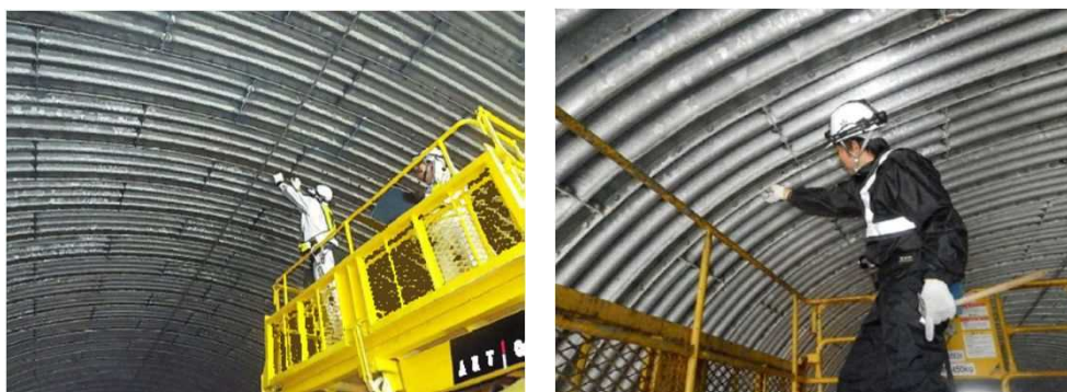
ボルトの緩み・脱落点検状況
