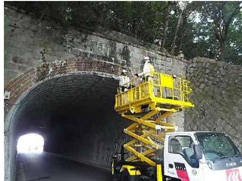
トンネル点検
