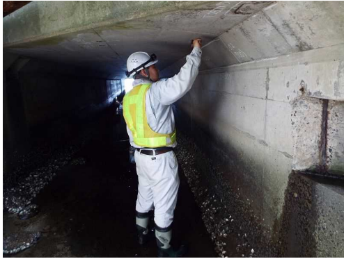
橋梁（BOXカバート）点検
