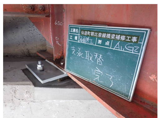
ゴム支承に取替え
