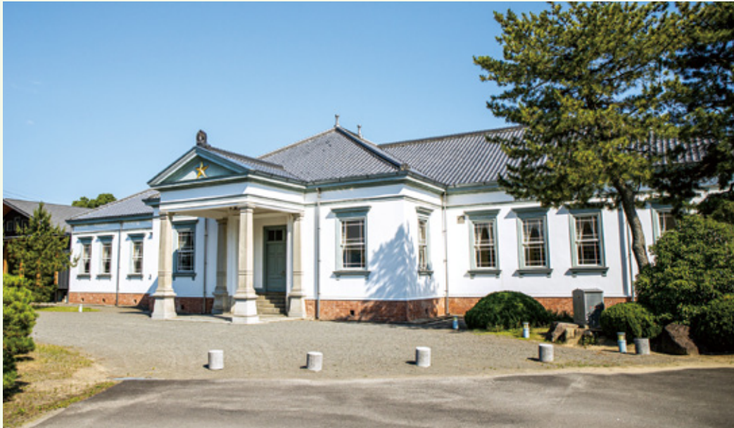
【正面玄関】切妻造りに石の角柱が目をはきます。
