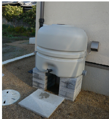
雨水貯留施設
