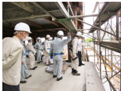
▼現地調査状況
