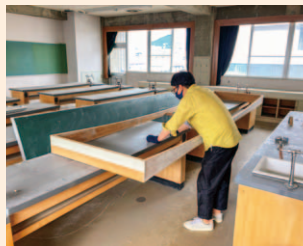
補強材を入れるために寸法を計測中
