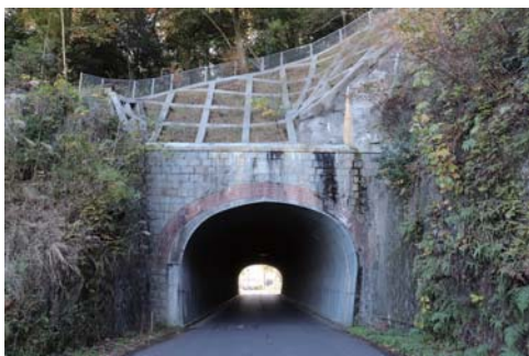
琴平参宮電鉄跡 岩崎隧道（南部地域）
