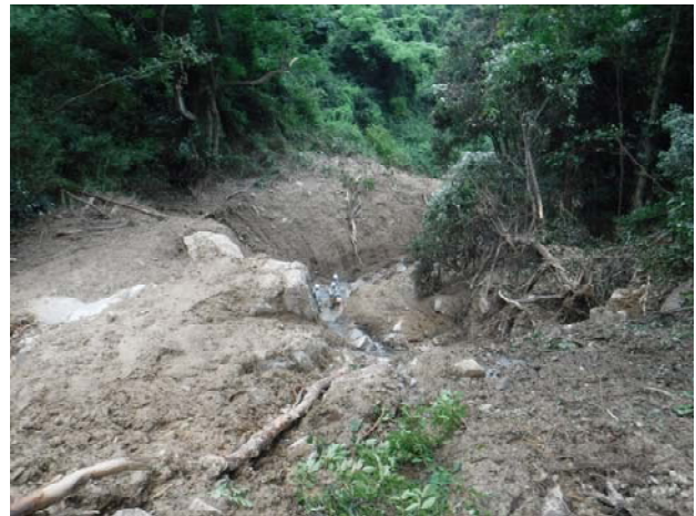
岩崎川土石流の 崩壊源頭部（大麻町）
