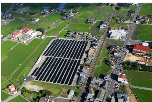
太陽光発電所
