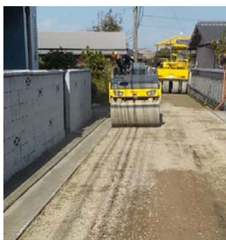
生活道路の整備
