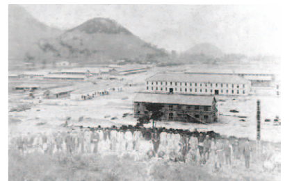
第十一師団工兵第十一大隊建築現場
