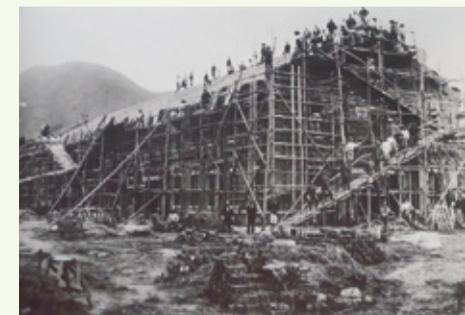
南棟の工事中の写真。煉瓦積みを終え、屋根にかかるところ。写真提供/水尾写真館
