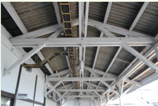
ホームの天井には、大正時代の木組みが残されています。
