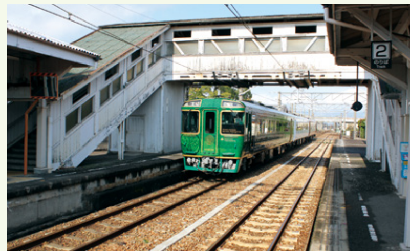
ホームの北端に架かる跨線橋は明治22（1889）年のもので、骨組みには輸入されたレール材（Barrow Steel製）が使われています。大正時代の構造がそのまま残されています。
