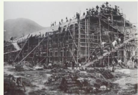
南棟の工事中の写真。煉瓦積みを終え、屋根にかかるところ。写真提供/水尾写真館
