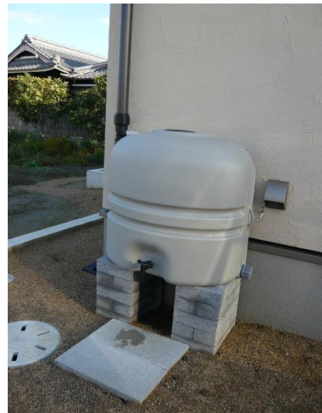
【 雨どいに実施された雨水貯留槽 】
