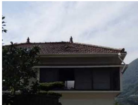
屋根瓦飛散
