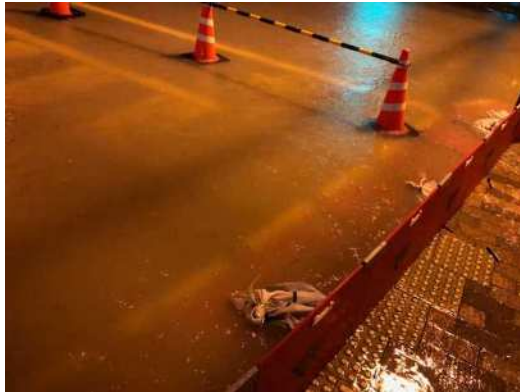
パネル土嚢設置状況(右に浸水していないのがわかる)
