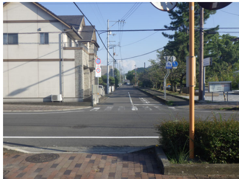
起点交差点部の状況 一高西側線を望む
