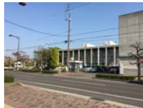
②計画地北側県道と現普通寺市庁舎
